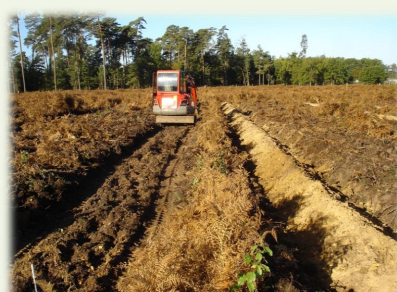
Octobre 2010. Préparation du sol à la mini-pelle
