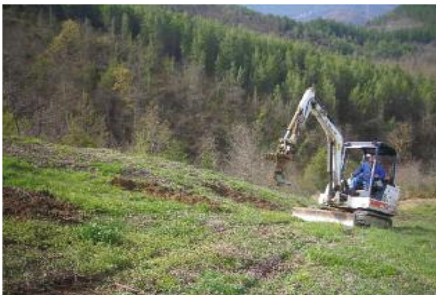
Réalisation de potets travaillés en montagne, perpendiculaires à la pente
