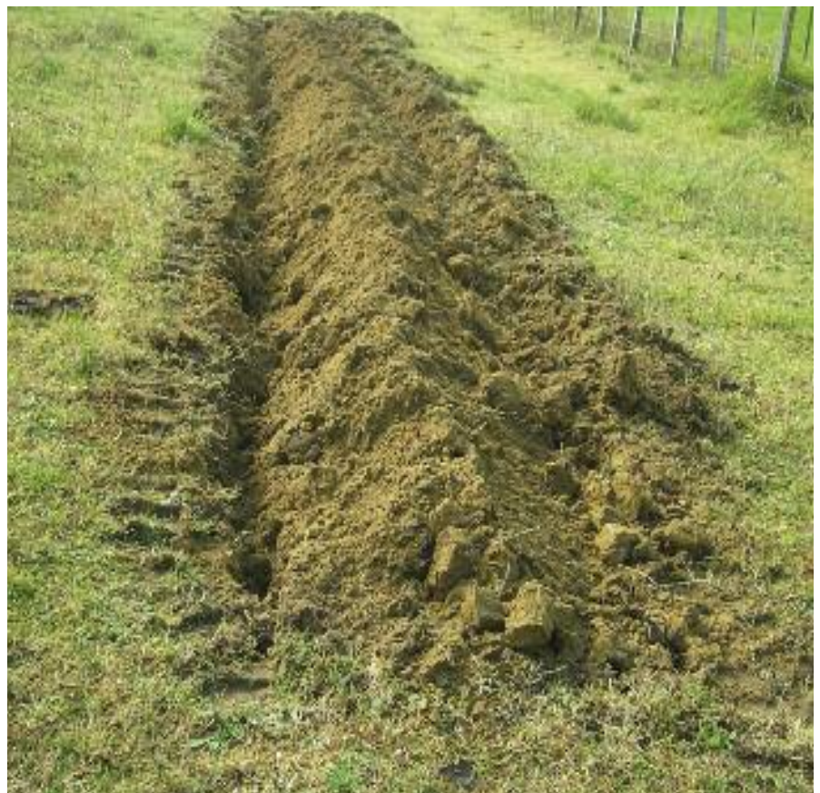
Bande « 3 B » en boisement de terre agricole, sur prairie (bombement végété « microfossés » latéraux bien visibles)
