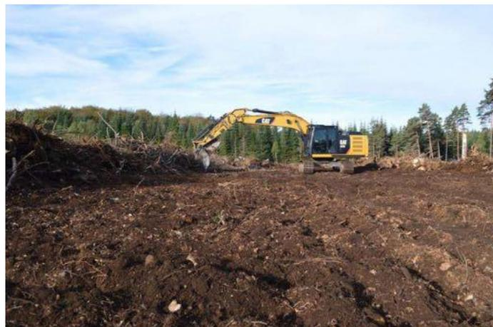
Figure 18 : Préparation du terrain à l'aide d'une dent de dessouchage à La Celle d'Auvergne (Vidal, CNPF-IDF).
