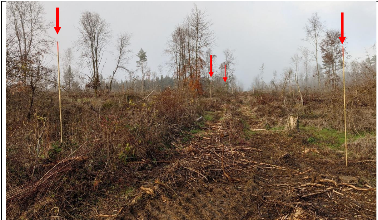
Entrée du cloisonnement matérialisée par une paire de piquets, puis alignement des piquets sur un seul côté, tous les 15 m.
