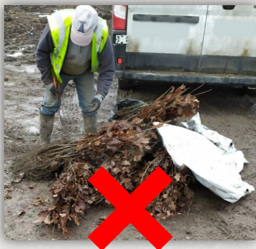
Habillage réalisé au sol
